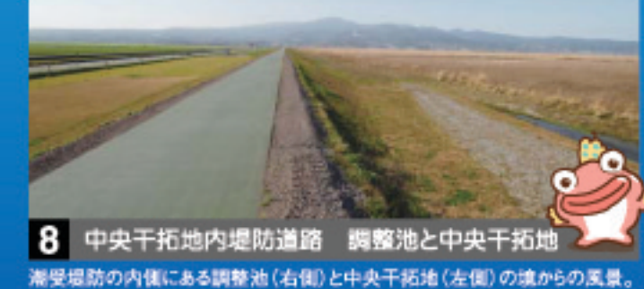
8 中央干拓地内堤防道路 調整池と中央干拓地 潮受堤防の内側にある調整池(右側)と中央干拓地(左側)の境からの風景。
